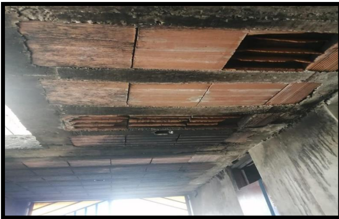
Vista de la estructura de la Vivienda dañada, se recomienda evaluacion estructural por un ingeniero.
