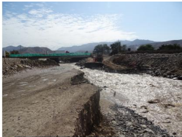
CORTE DEL DESVIO PROVISIONAL EN APROX. 12 M. AL FONDO SE PUEDE APRECIAR EL TRANSITO POR EL PUENTE.
