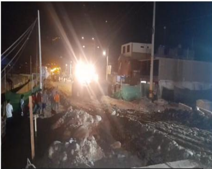
HABILITACION DE RAMPA DE ACCESO HACIA EL PUENTE PARA REANUDAR EL TRANSITO
