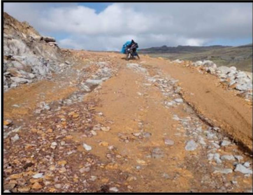
SE OBSERVA LOS DAÑOS OCASIONADOS A LA CARPETA DE AFIRMADO Y CUNETAS POR LAS LLUVIAS INTENSAS
