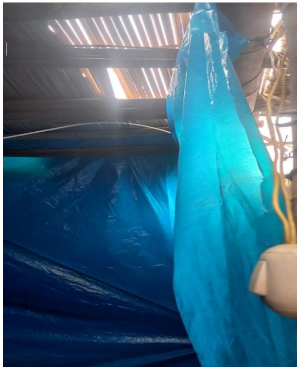
IMAGEN 03 Se observa el mal estado del plástico que cedió por El Peso del agua que se acumuló
